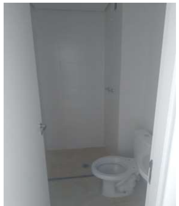
BANHEIRO - TORRE D
